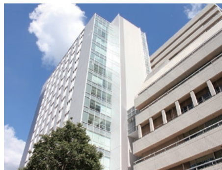
図1 2013年8月に落成した新教育研究棟 15階建ての建物に図書館、大教室、学生自習 室、医局、研究室などが入っている。
